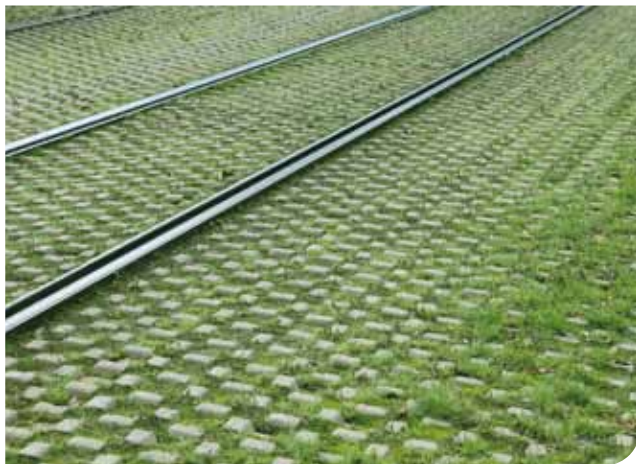
Kiveykset voidaan tehdä vettä läpäisevillä materiaaleilla.
